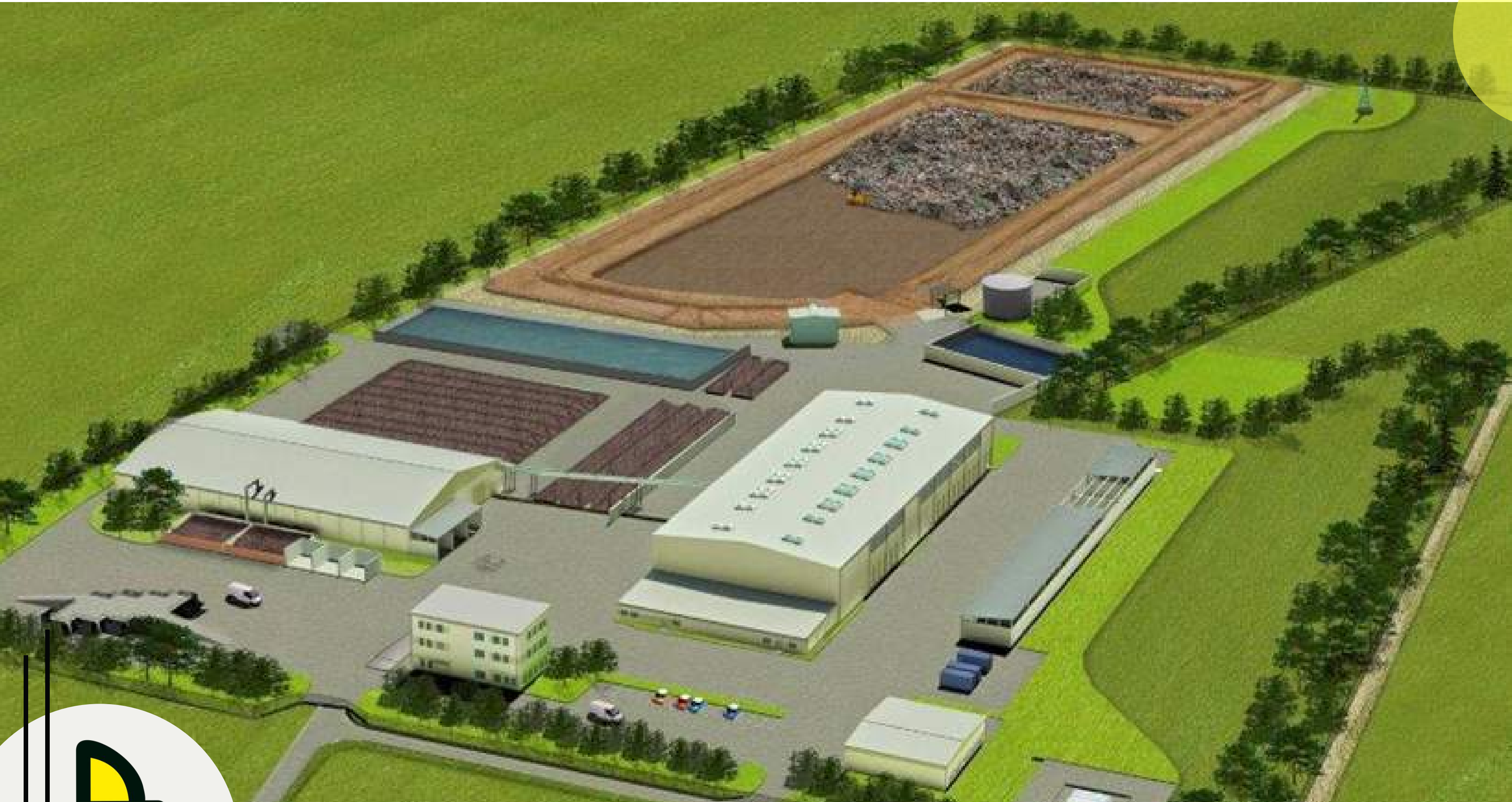
Wizualizacja projektu Zakładu: sortownia, kompostownia, kwatera składowania, budynki uzupełniające.
